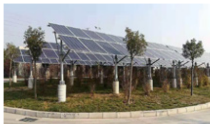
太阳能发电设施
