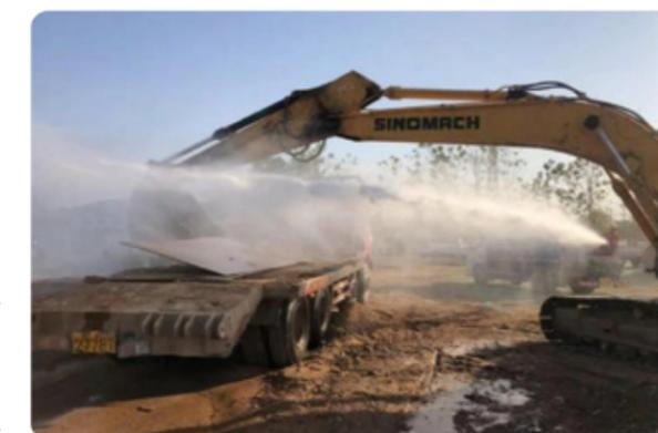
✓ 扬尘管理：积极采取现场降尘及绿化技术，对产生的扬尘采取湿法作业，并在施工现场出入口设置冲洗车辆设施，对冲洗车的用水进行循环使用；
