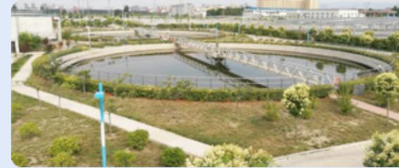
焦作市第一污水处理厂采用前置缺氧改良型A/A/O工艺，处理规模10万吨/天。新厂区迁移后于2017年8月正式投入运行，出水水质达到《城镇污水处理厂污染物排放标准》(GB18918-2002)一级A标准。
