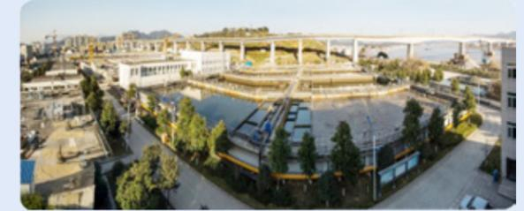
温州市西片污水处理厂总处理规模25万吨/天：一期10万吨/天，采用CAST+MBBR工艺；二期15万吨/天，采用多段A/O工艺。一期提标以及二期扩建于2018年1月投入运行。出水水质达到《城镇污水处理厂污染物排放标准》(GB18918-2002)一级A标准。
